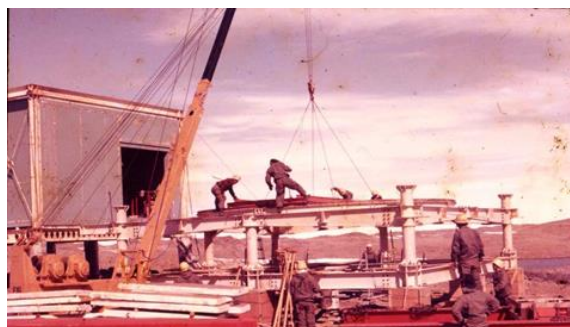
ロケット発射設備の建設作業
