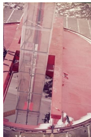
写真3 完成したビニールハウス（保温槽）。左下に保温のダクトが見える。
