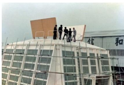
写真2 仮組立てされた発射台上屋ドーム
