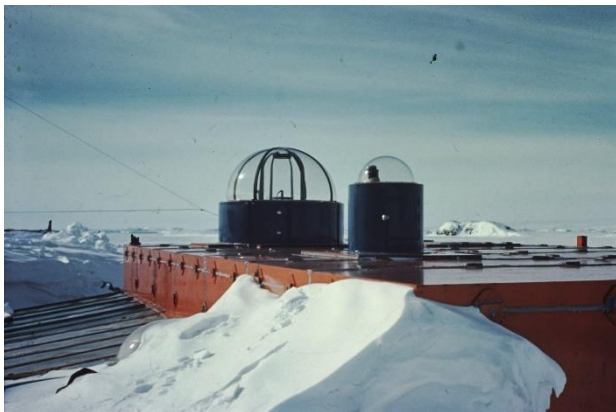
観測棟外観。左端全天カメラ等【1次隊の際は、光電受光器（中）、分光器（右）は、屋上のレンズのみで内部機械は3次隊から設置】
