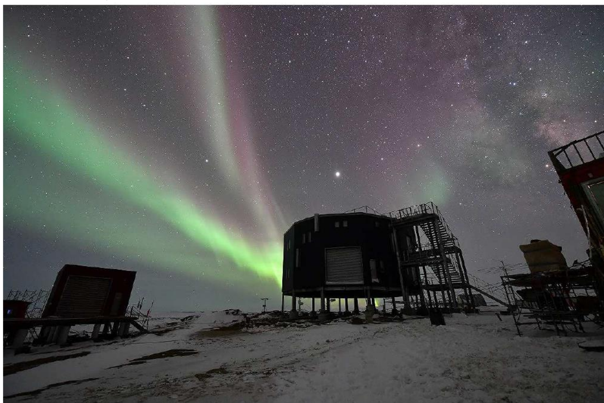
59次隊で建屋が完成した基本観測棟。旧管制棟に代わって気象棟の北側に建てられた。
